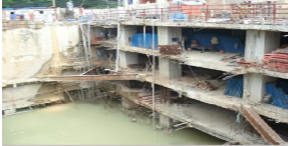
Hình 2. Hiện trạng tầng ngầm toà nhà Pacific, TPHCM sau khi xảy ra sự cố
