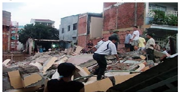
Hình 1. Căn nhà 4, 5 tầng số 792C sụp năm 2007
