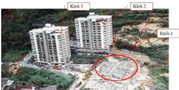
Hình 4. Block 1, toà nhà Highland Tower (Malaysia) sụp năm 1993
