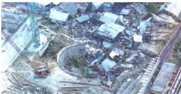
Hình 5. Toàn cảnh trạm bơm nước thải ở Bangkok (Thái Lan) bị sụp năm 1997
