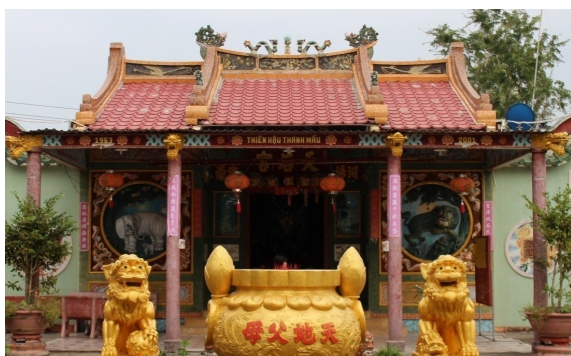
Hình 7: Mặt tiền miếu Thiên Hậu chợ Cái Keo, huyện Đầm Dơi, tỉnh Cà Mau (tác giả chụp năm 2015)
